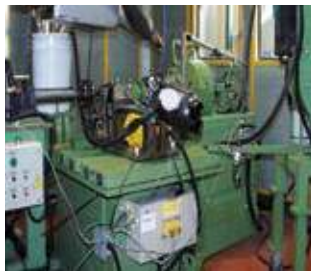
BANCS D'ESSAIS ET DE TEST
