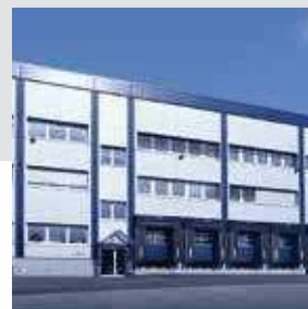
Inauguration de la nouvelle centrale de distribution en 2013
